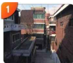
현장방문 건물 기본정보 및 현황파악
